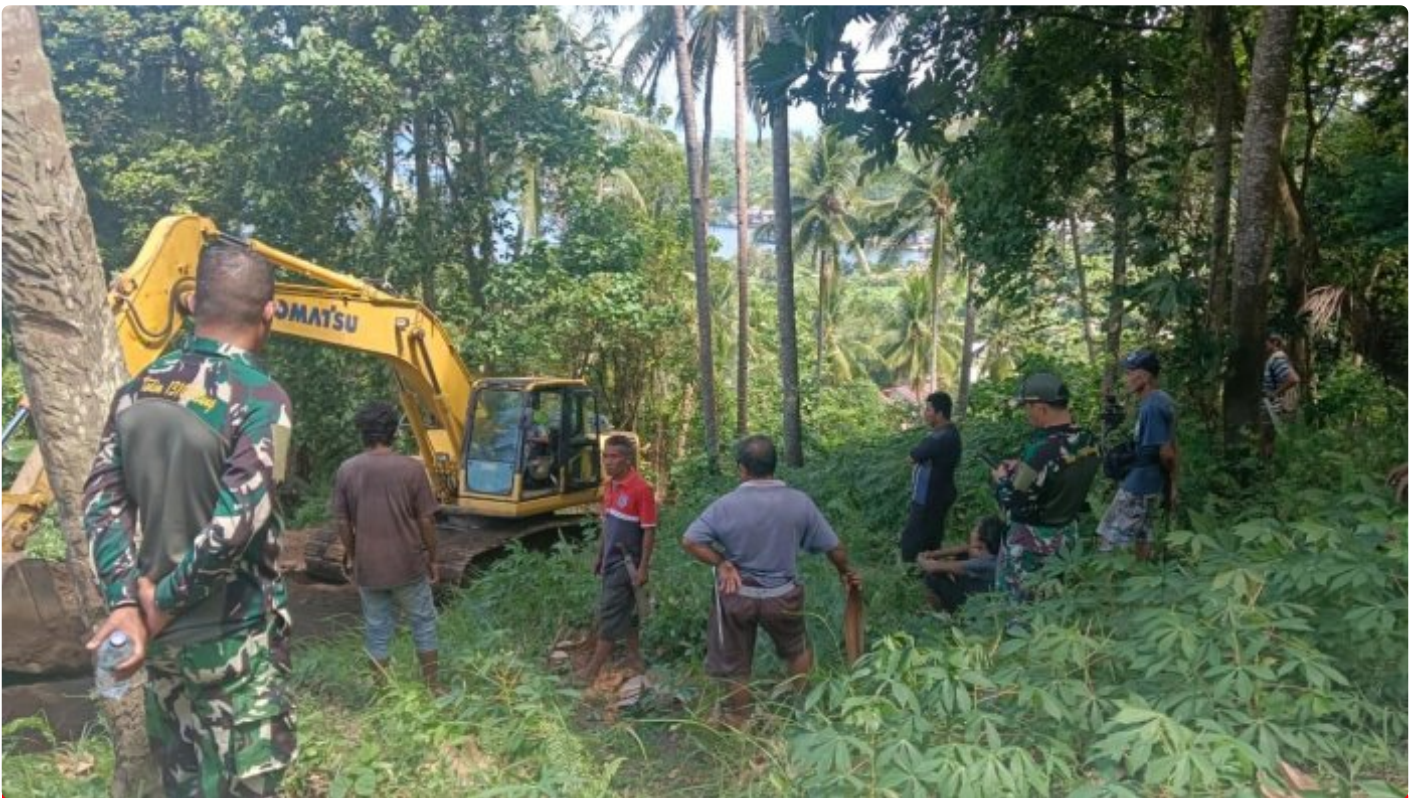
Dan Satgas TMMMD, Dandim Tinjau Pekerjaan Permtisan Jalan Pertanian
