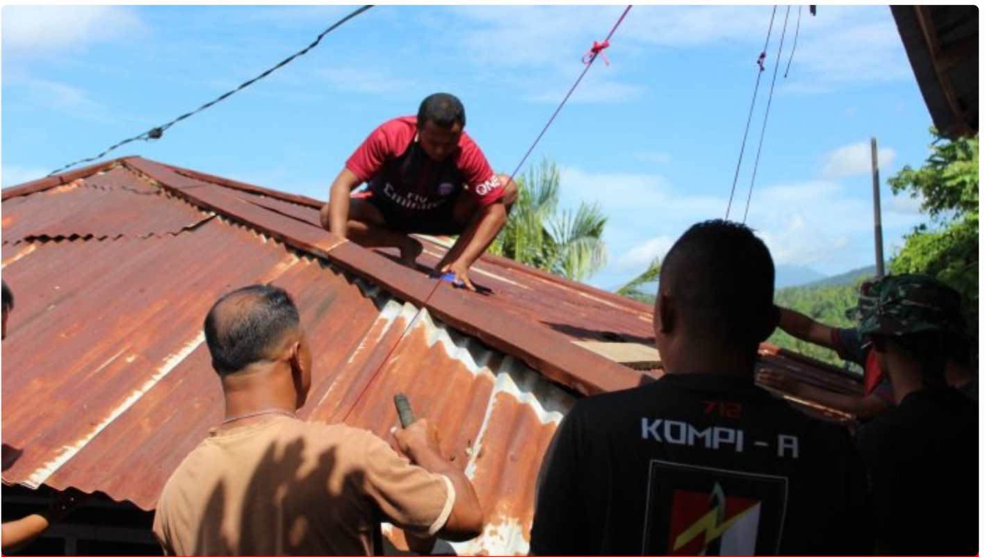
Pembongkaran Bangunan Rumah lama, Keluarga Gavin Karaki Pemema Bantuan. RTLH TMMD Ke 116 Kodim1310 Bitung
