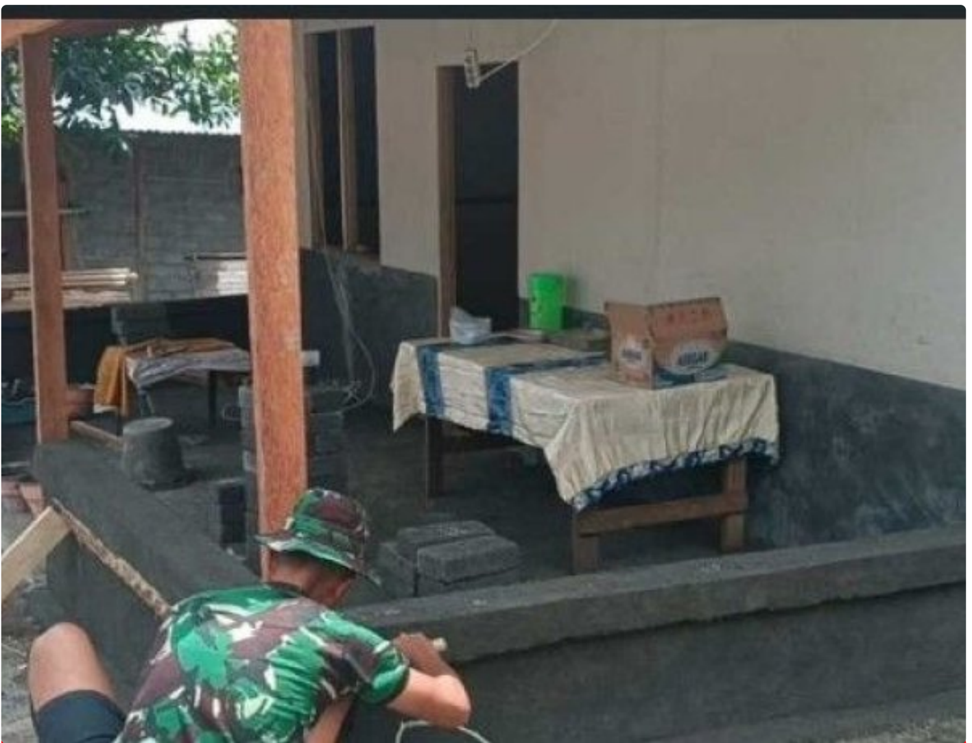
Satgas TMMD Kodim 1310 Bitung dalam Pekerjaan RTLH
